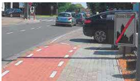
Les retours sur la chaussée créent des zones de danger.
